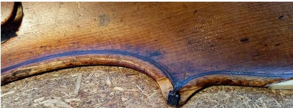
Výložka v růžku byla natolik setřena, že její špička musela být zvednuta vyklínkováním. To je nutné, aby profil nového růžku mohl mít potřebnou výšku.
