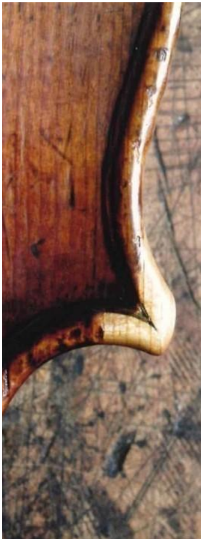
Obr. 12, 13, 14 | Oprava růžku a vysazení opotřebovaných okrajů.
