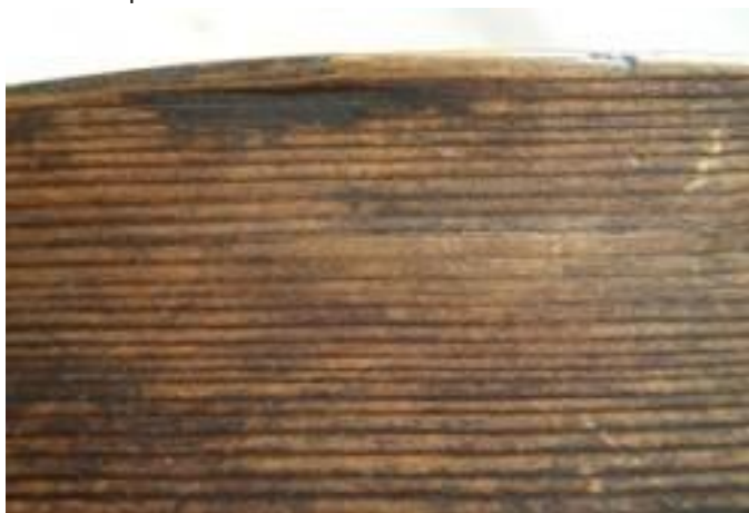
Obr. 4 | Propadlá deska dokládající uvolněné žebro. Foto: J. Čepelák.
