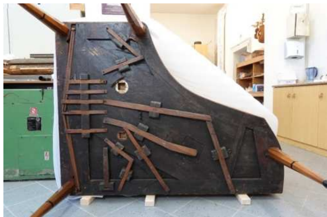
Obr. 19 | Detail spodní strany nástroje a původního ovládání pedály. Foto A. Bitljan.
